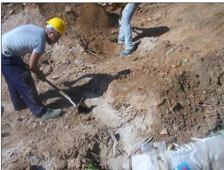
Fig. 9.- Vista dels treballs d'excavació al mur u.e.04
